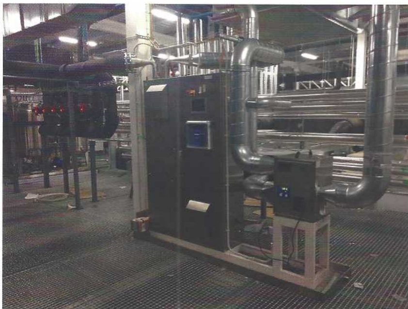
Abbildung 1: Integrierter Generator zur Erzeugung von max. 200 m 3 /h verdampftem Wasserstoffperoxid zusammen mit einem Luftentfeuchter (Quelle aller Abbildungen: Steris).
